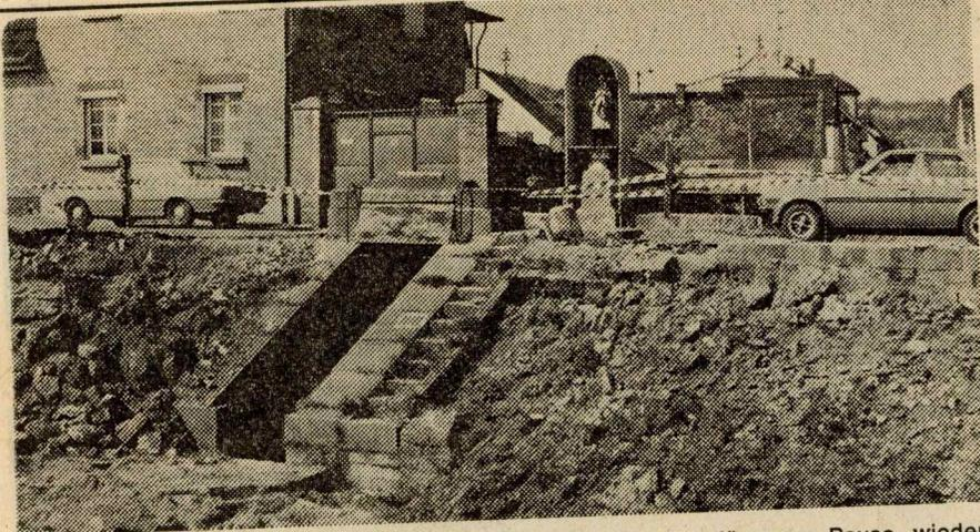
DIE ARBEITEN am Nackenheimer Rheinufer gehen nach längerer Pause wieder weiter. An dieser Stelle wird der Schiffermast wieder errichtet. Aus diesem Grund mußte die Hochwasserschutzmauer auf einer gewissen Länge entfernt werden. Hochwasserschutzvorrichtungen werden allerdings beim Bau des Schiffermastes in die Anlage integriert.
